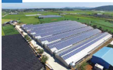
999kW 전북 익산시 남산면 구평리 221-6번지 (육계)
