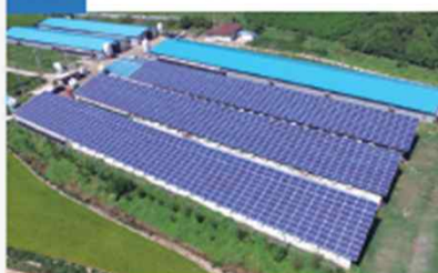
400kW 전북 김제시 백산면 수족리 531번지 (육계)
